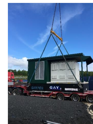
Figure 92 : Livraison d'un poste électrique (source : URBASOLAR, 2022)
