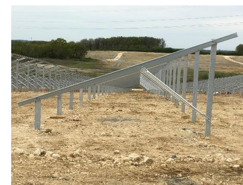
Figure 90 : Exemple d'une structure porteuse complète avant mise en place des panneaux (source : URBASOLAR, 2022)
