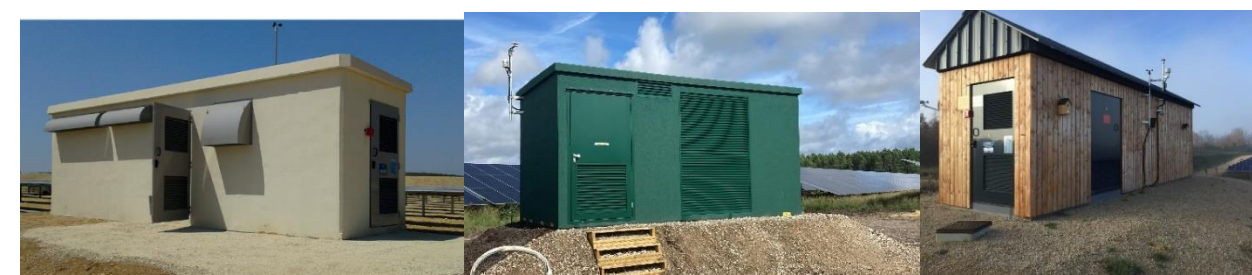
Figure 93 : Exemples de local en RAL 1015 (à gauche), en RAL 6005 (au milieu) et à bardage bois (à droite) (source : URBASOLAR, 2022)
