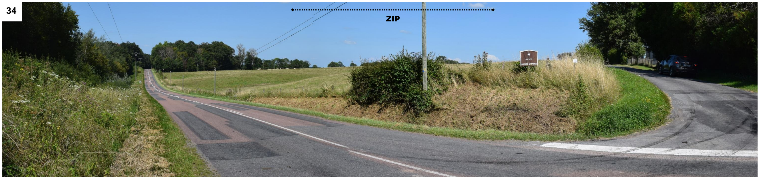
Figure 61 : Croisement de la D34 avec le sentier local au nord de la Petite Machine (source : ATER Environnement, 2021)
