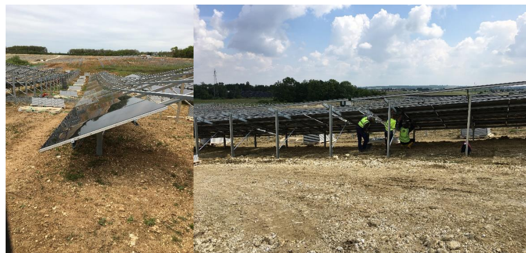
Figure 91 : Exemples de mise en place de panneaux sur les chantiers (source : URBASOLAR, 2022)
