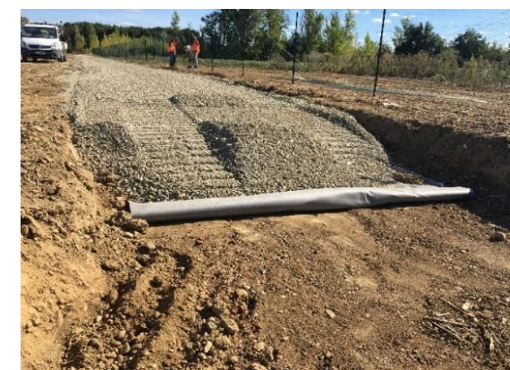
Figure 87 : Exemple de réalisation de voie d'accès interne (source : URBASOLAR, 2022)
